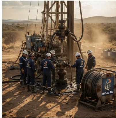
Intervención de campo y equipos de bombeo / rehabilitación
